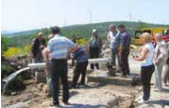
ATÇILAR KÖYÜNE SU SAĞLANMASI (ALİAĞA-İZMİR) / WATER SUPPLY TO ATÇILAR VILLAGE (ALİAĞA-İZMİR)
